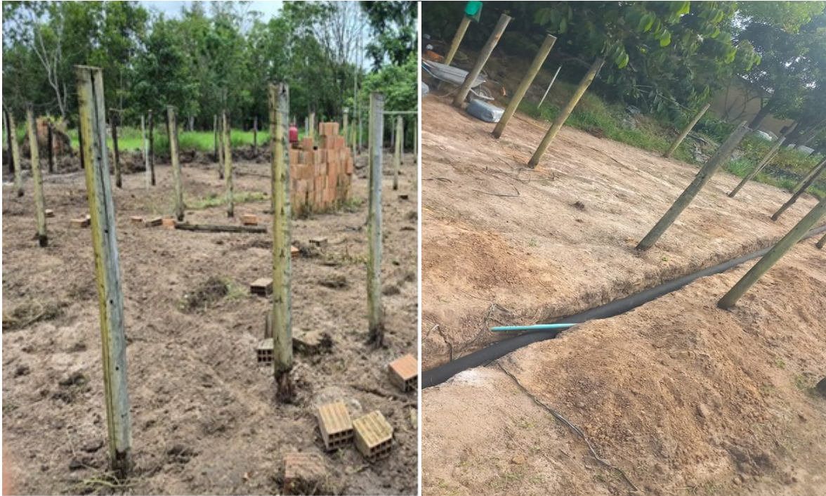
Figura 23. Retirada da rafia e instalação dos tubos de drenagem na área de rustificação.
