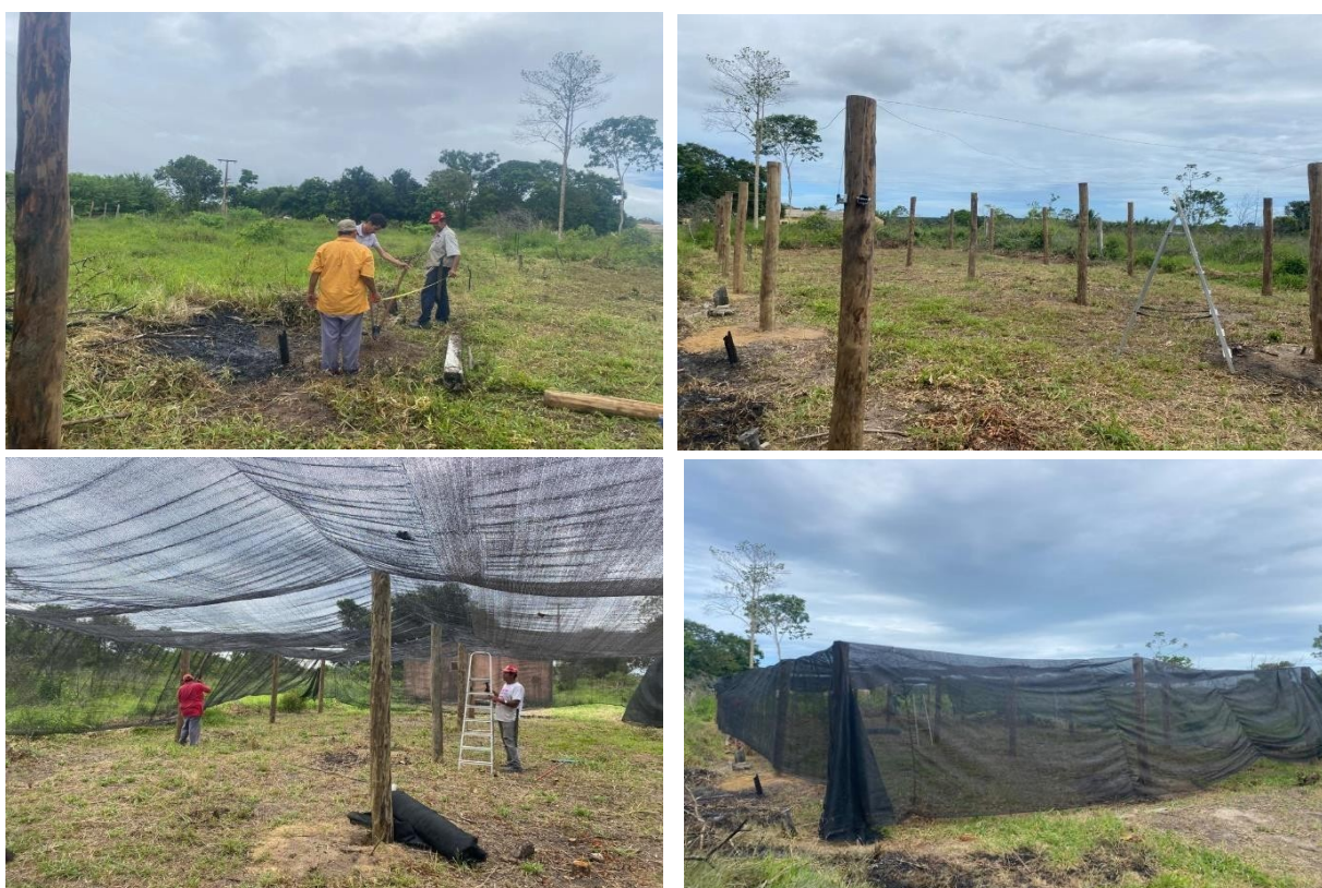
Figura 47. Imagens da construção do viveiro do Núcleo Sapucaia
